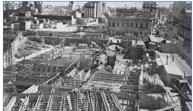
Cimientos del Complejo.
