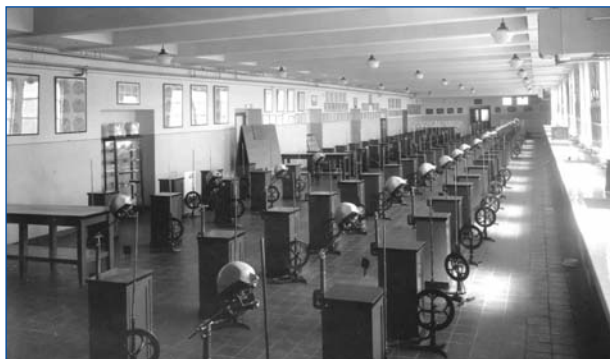
Sala de Técnica de Operatoria. (Nótese los tornos a pedal)
