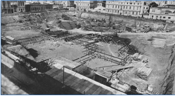
Excavación del Complejo.
