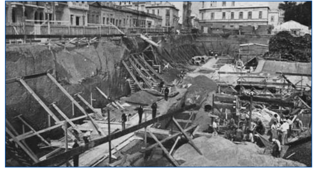
Excavación del Complejo.
